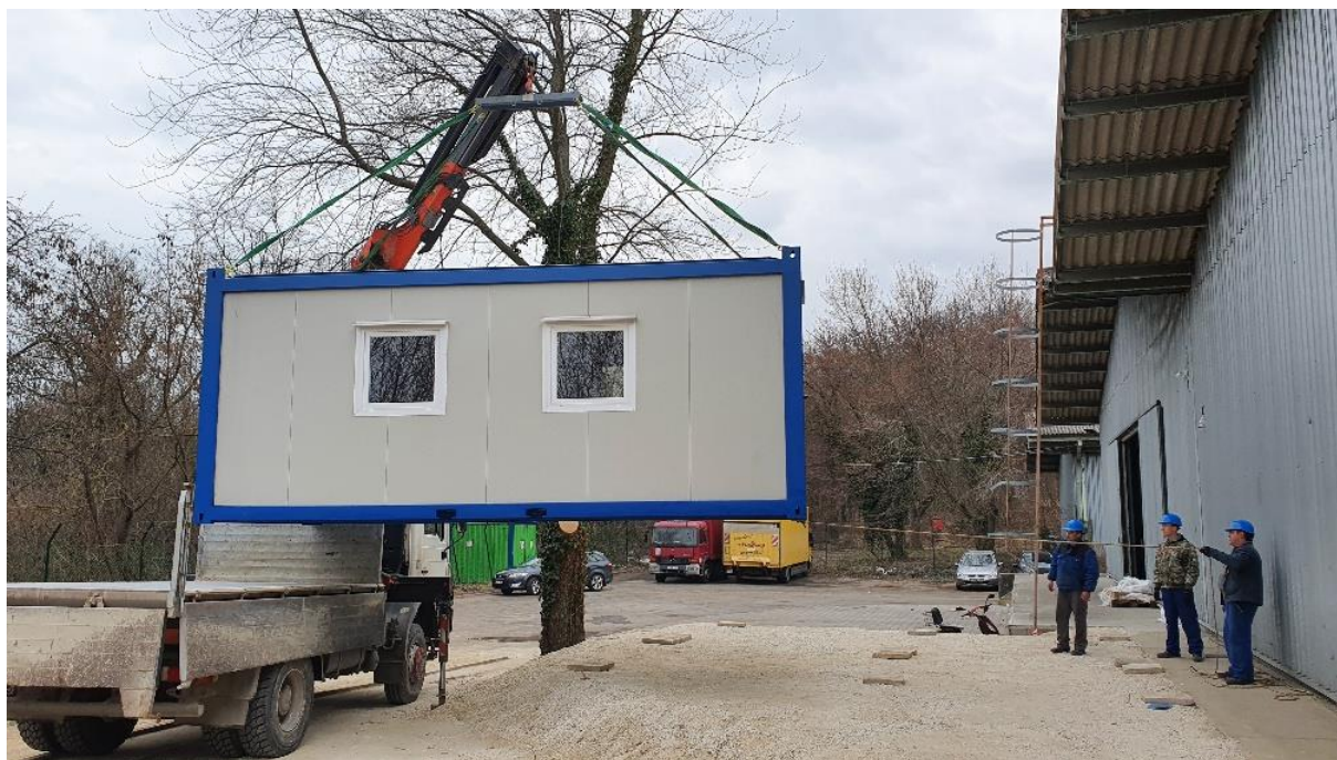
1. kép: KonteMax Office 20 irodakonténer telepítése daruval
