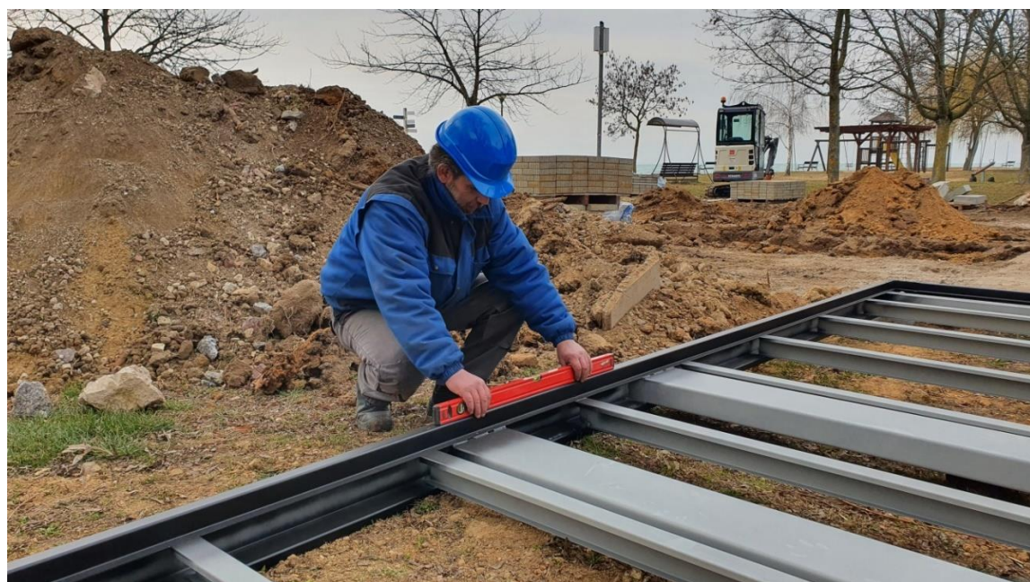
2. kép: alsó keretek pontalpra helyezése
