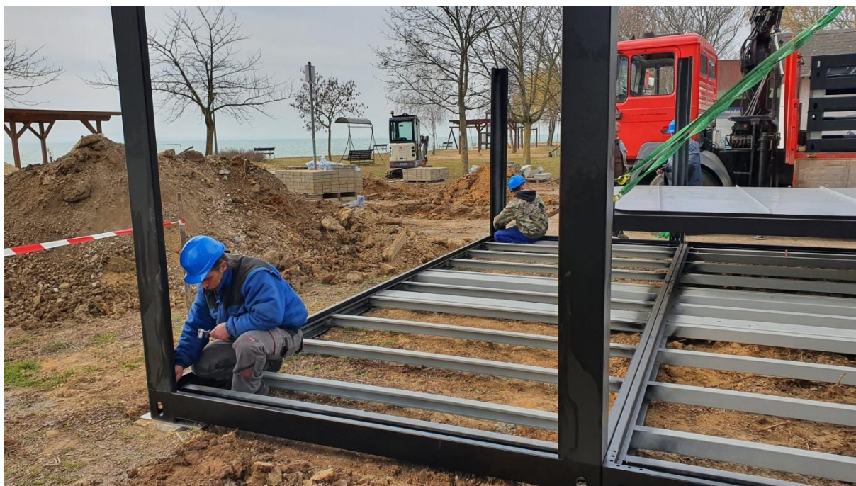
4. kép: függőleges oszlopok felhelyezése
