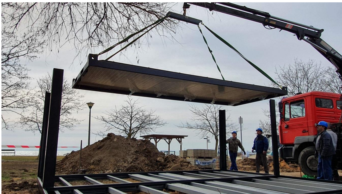
5. kép: felső keret helyére illesztése
