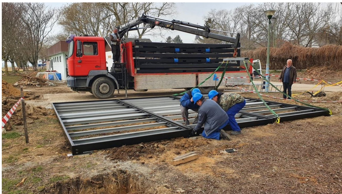
2. kép: alsó keretek pontalpra helyezése
