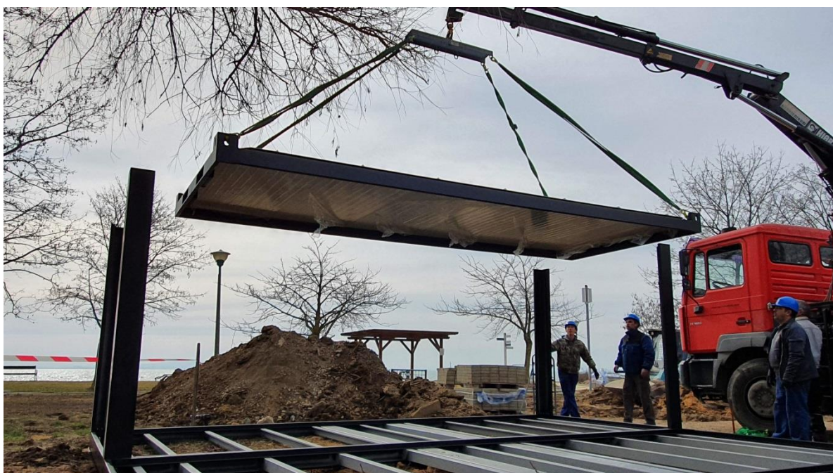
4. kép: felső keret helyére illesztése
