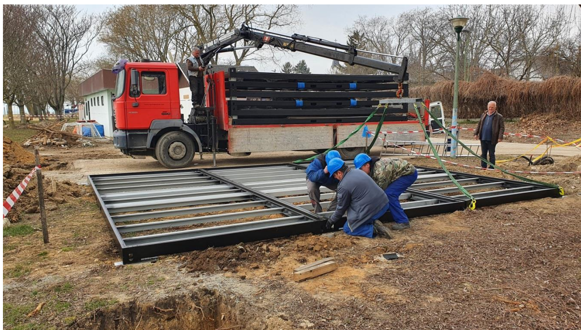
1. kép: alsó keretek pontalpra helyezése
