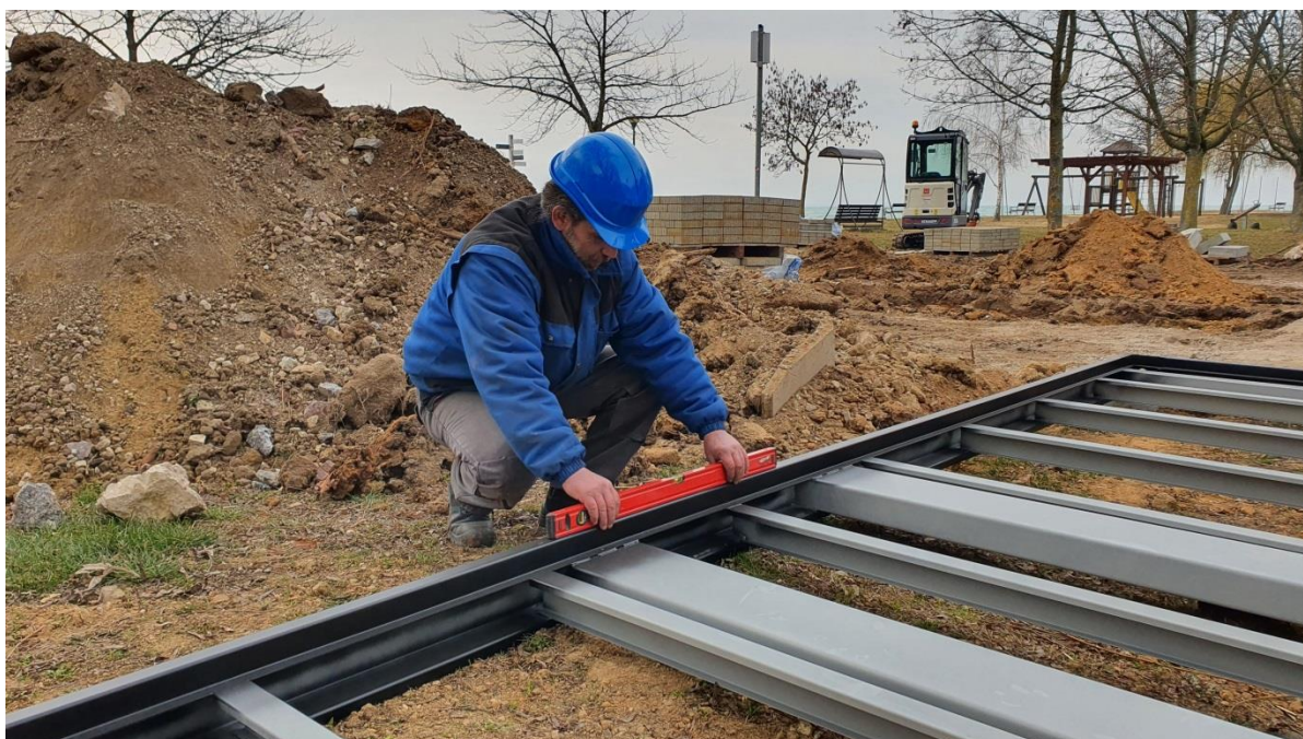
2. kép: alsó keret szintezése vízmértékkel
