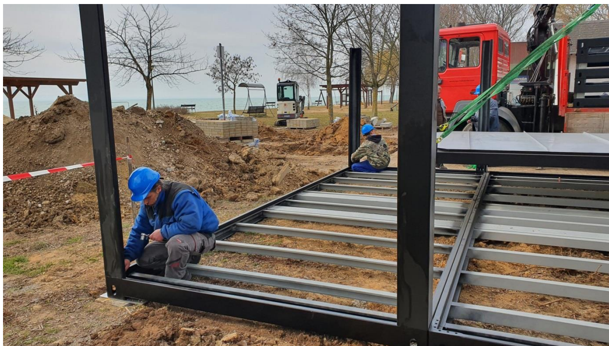
3. kép: függőleges oszlopok felhelyezése
